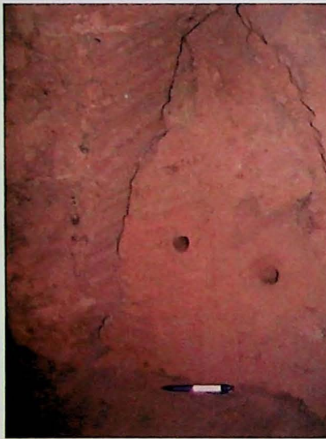
Foto 09. Detalhe das marcas deixadas na rocha pelo martelete.
